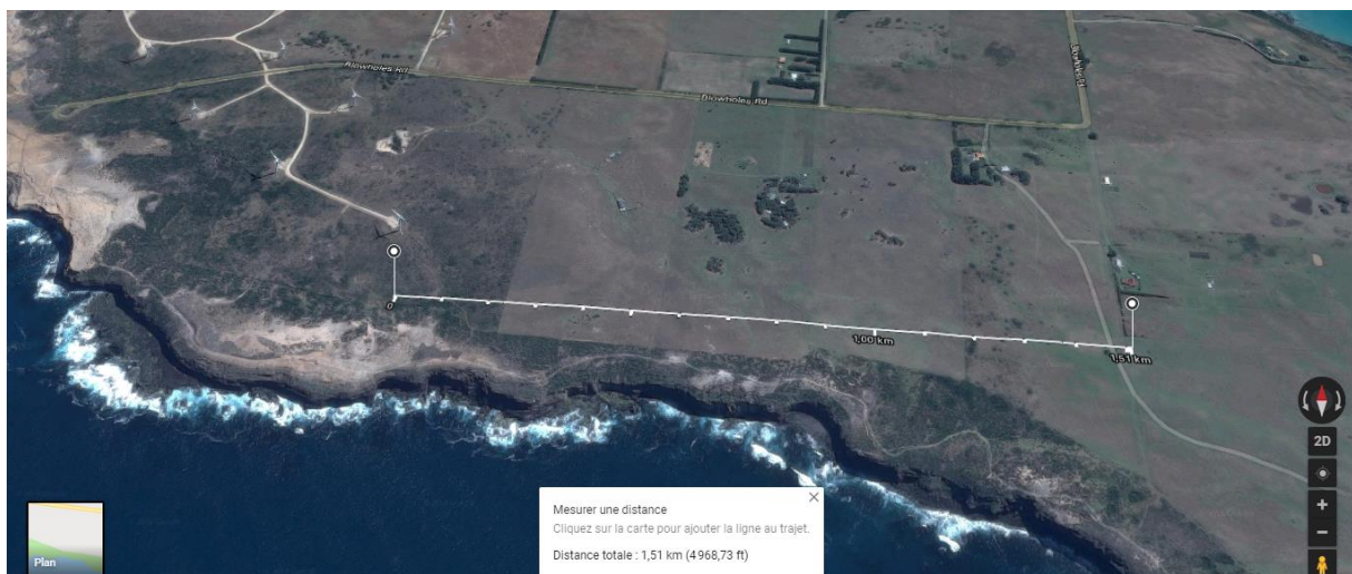
Plan et vue aérienne de la ferme éolienne de Capebridgewater sur la côte sud de l'Australie et distance séparant la turbine la plus proche de la maison étudiée : 1560 m
